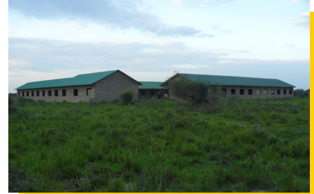
Het complete complex, juli 2011.
