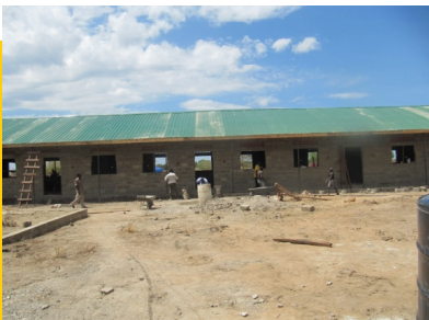
'Groene daken voor het schoolgebouw in Cuey Machar, april 2010.'
