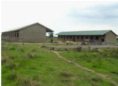
Foto van de bouw, zomer 2010.
